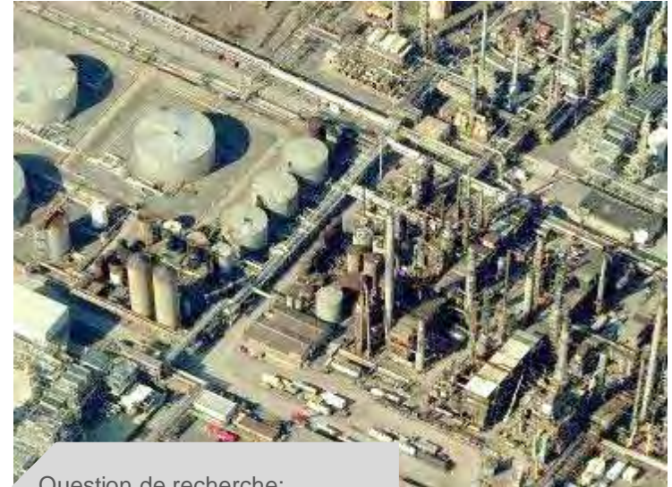
Vue aérienne du secteur industriel
