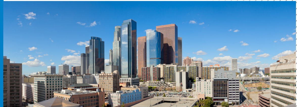
La renaissance de Bunker Hill a initié le développement d'un centre-ville contemporain actuel.
