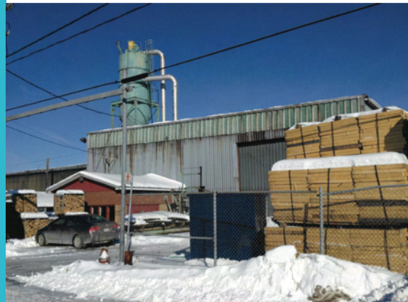
La cours à bois adjacente au métro De la Concorde
