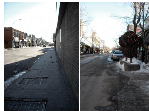
Aménagements nuisibles à la sécurité piétonne : trottoirs désuets et étroits, saillie inefficace.
