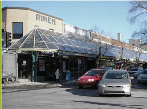
La marquise : régularisation du cadre bâti mais perte de points de repère.
