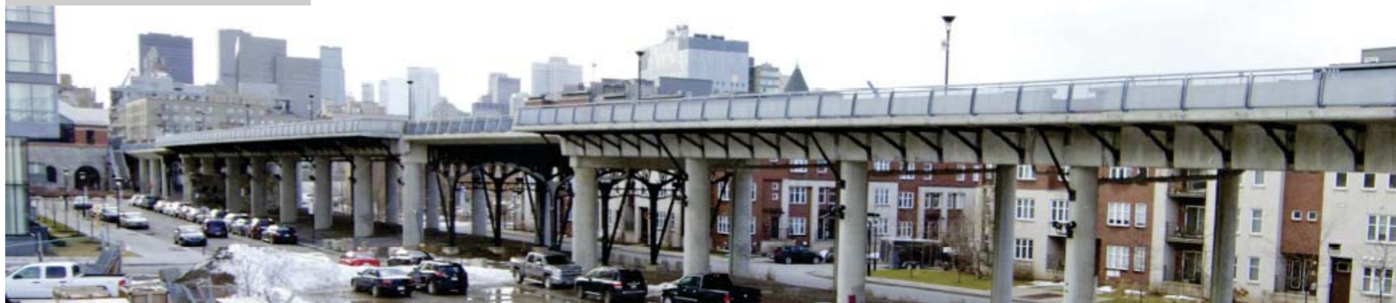
Le viaduc aujourd'hui
