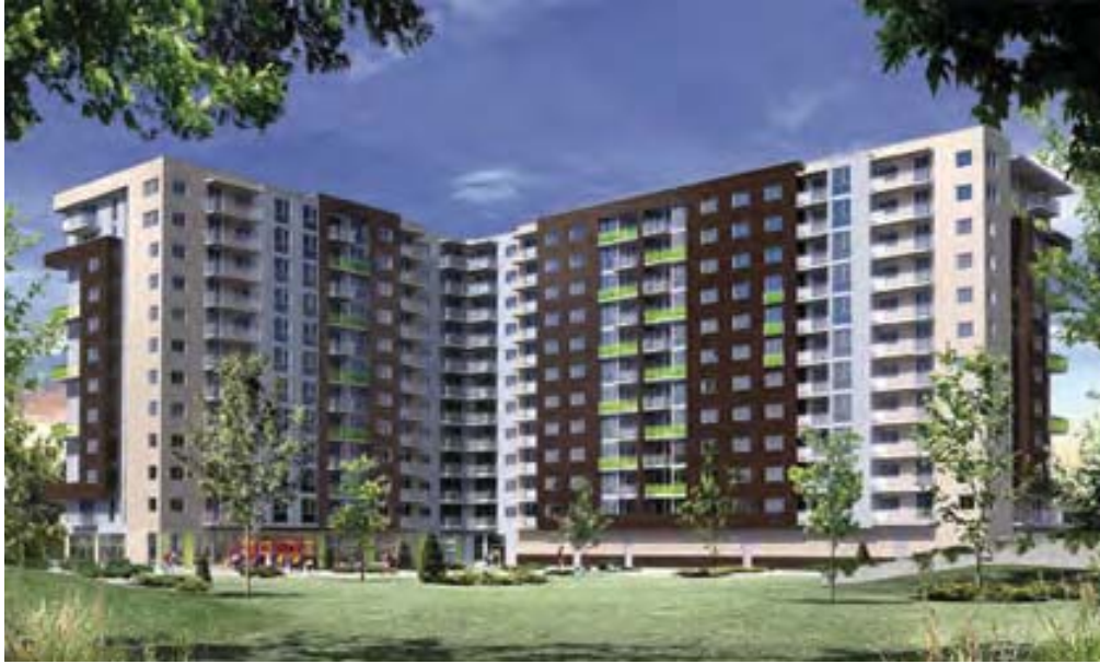
L'aménagement de services de proximité au rez-de-chaussée de la première phase du projet Cité l'Acadie est très avantageux pour les familles Source : Construction NCL
