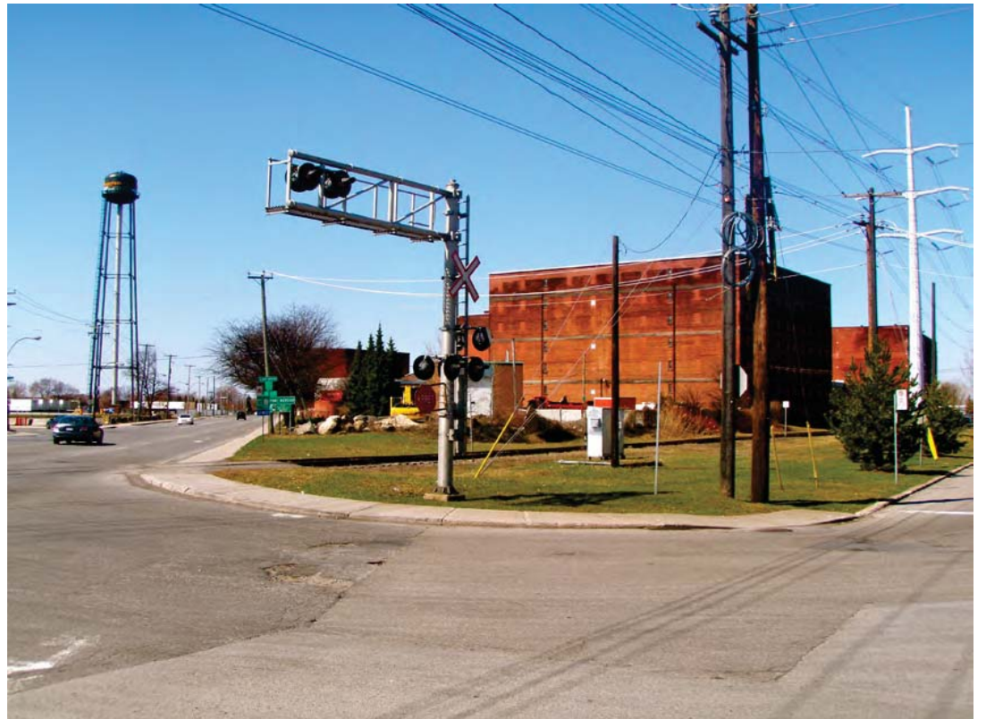
Le chemin de fer et les voies d'accès aux infrastructures urbaines ont favorisé l'implantation de la Seagram en ce lieu
