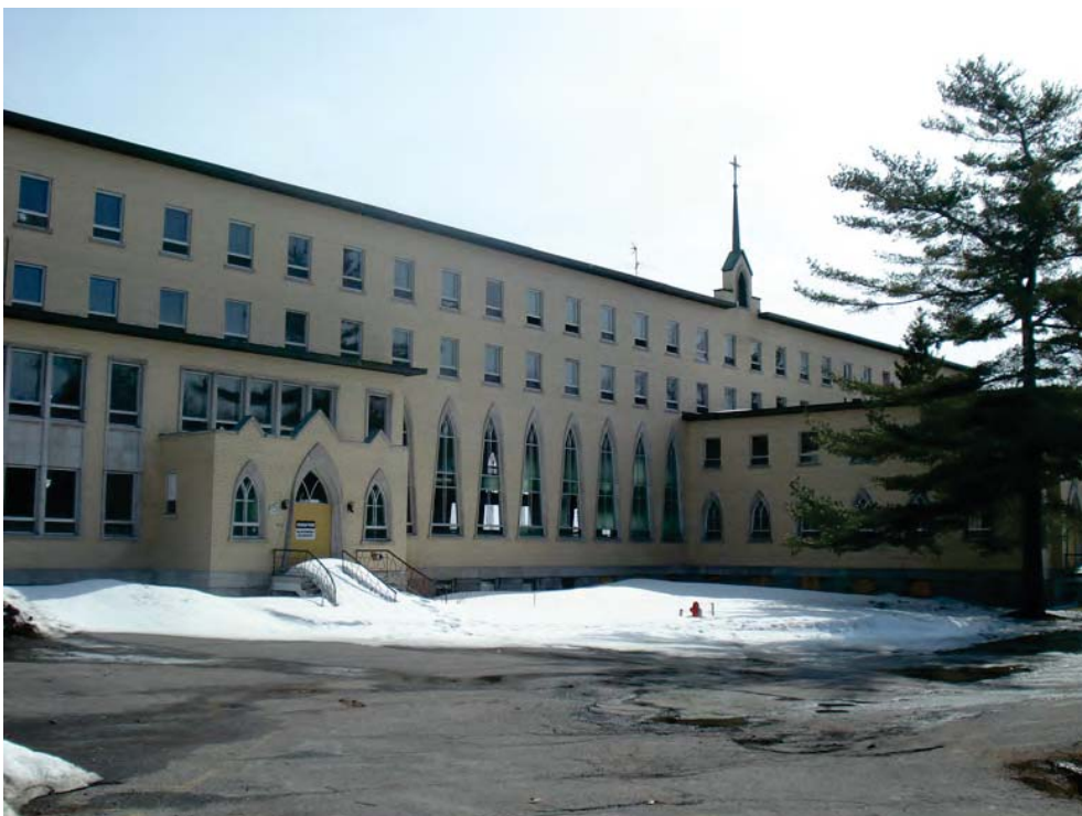
Bâtiment vacant en attente de reconversion
