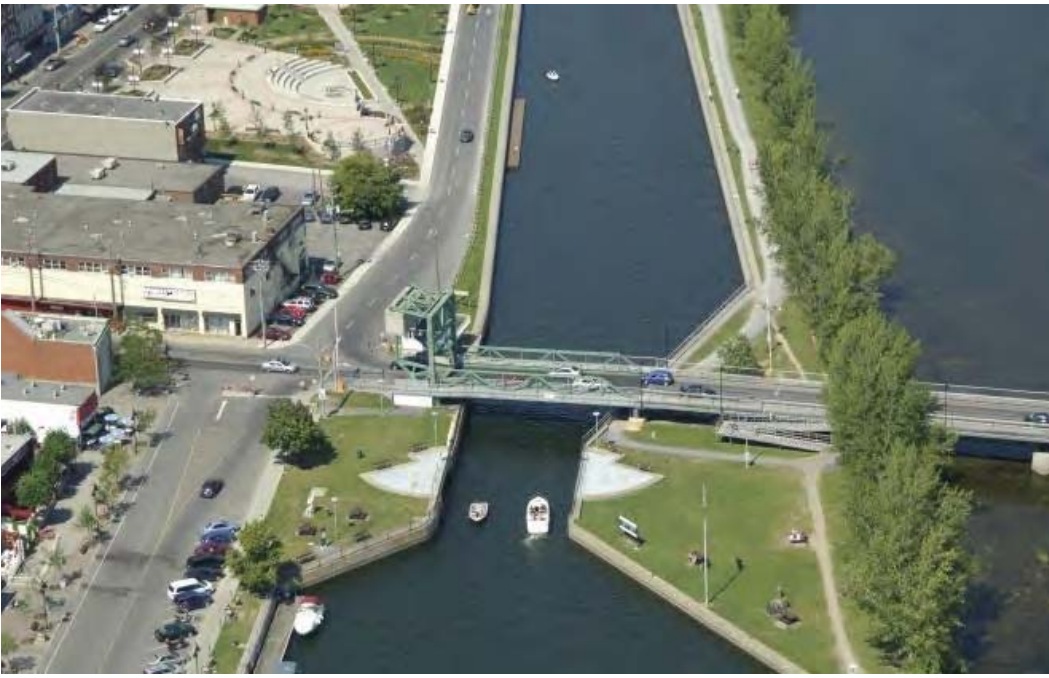
Particularité que ne possèdera pas le futur pont Gouin : un pont levis permettant le passage des bateaux sur le canal de Chambly Source : marinas.com
