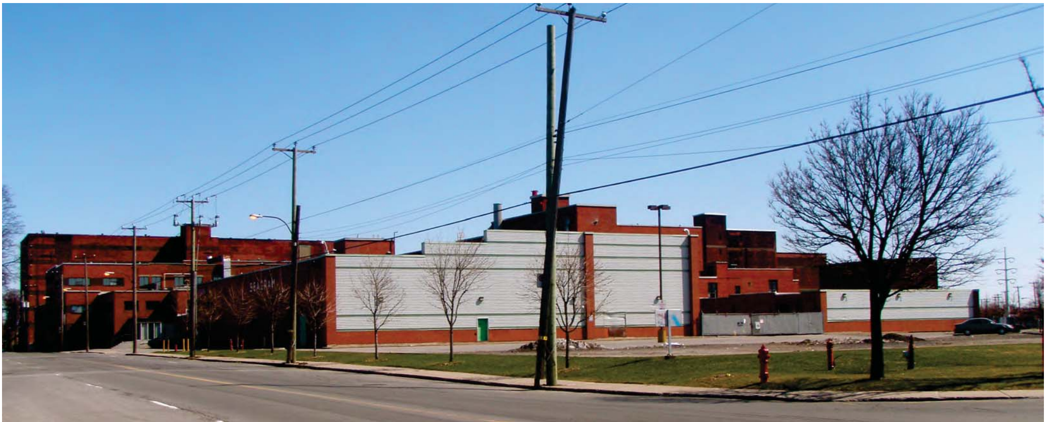
Les bâtiments encore présents sur le site sont de grand gabarit et ont une forte empreinte visuelle
