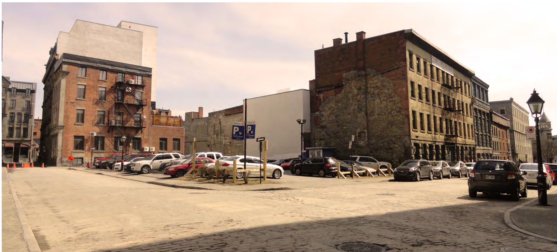
L'intersection des rues Saint-Nicolas et du Saint-Sacrement : la présence du stationnement occasionne un éclatement dans l'encadrement et rend l'espace illisible pour le piéton
