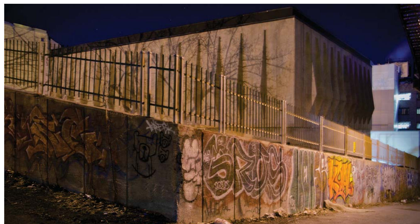
La discontinuité des volumes bâtis et la grande présence de graffitis sont caractéristiques du Quartier Latin. Sur cette photo on peut observer le poste de distribution électrique du centre-ville qui n'est qu'à quelques mètres de la rue Saint-Denis
