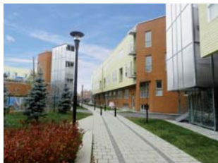
La Place Valois à Montréal reprend un ancien tracé ferroviaire et contribue à la revitalisation du quartier Hochelaga-Maisonneuve.
