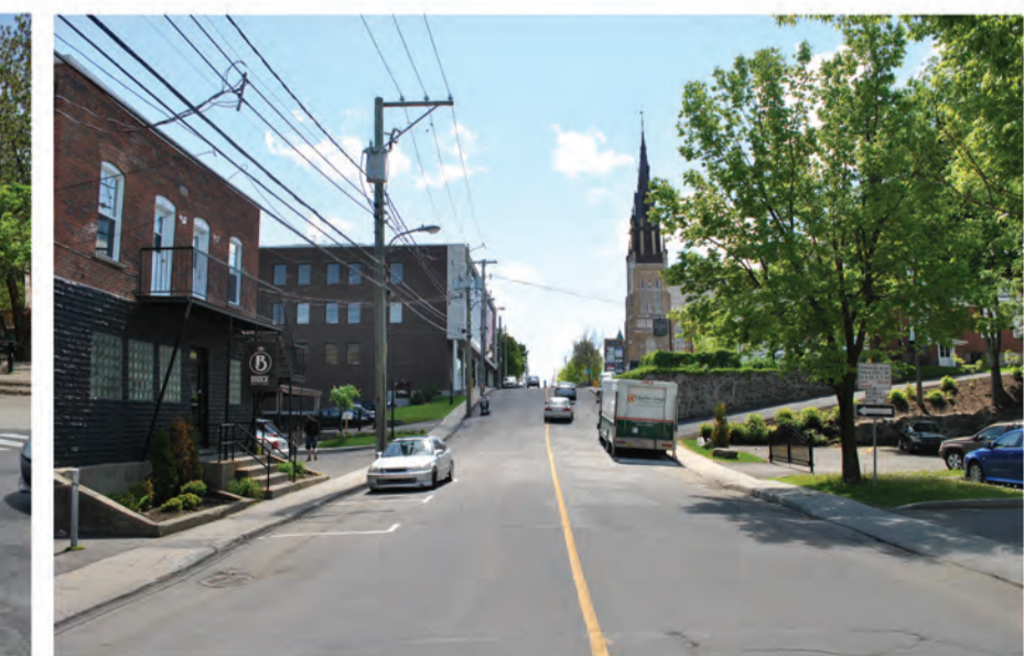
Figure 12: Rue Brock, entre les rues Girouard et Cockburn
