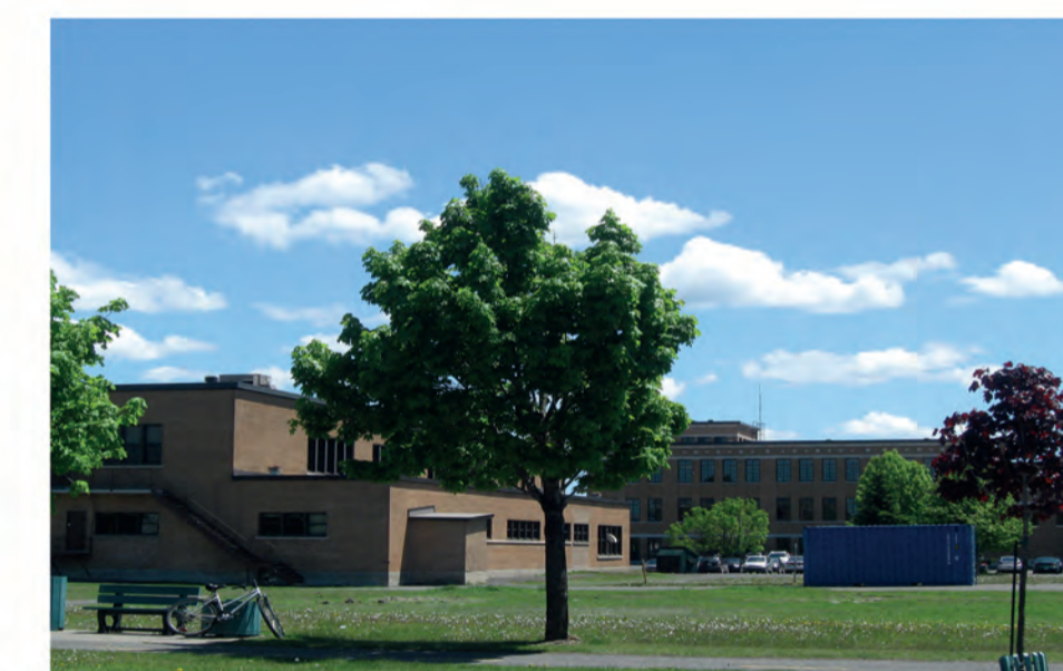
Figure 6: Débordement de la friche Des espaces délaissés près de la friche accentuent fortement l'impression de sa présence.
