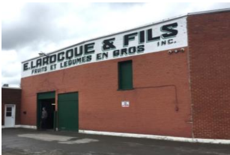
Un héritage manufacturier centenaire, face à la gare.
