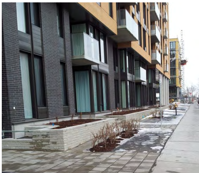
Figure 6 – Aménagement paysager devant le projet Quartier 54 sur le site des anciens ateliers municipaux Rosemont
