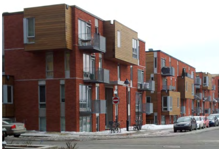
Figure 4 – OBNL Un toit pour tous sur le site des anciens ateliers municipaux Rosemont
