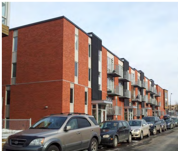
Figure 5 – Coopérative d'habitation des Coteaux verts sur le site des anciens ateliers municipaux Rosemont
