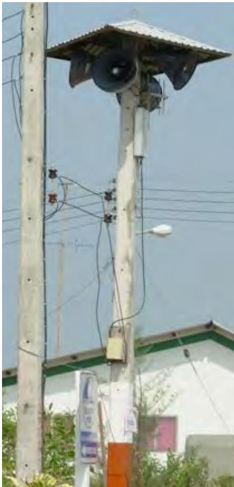
FIG 11. Système d'alerte secondaire
